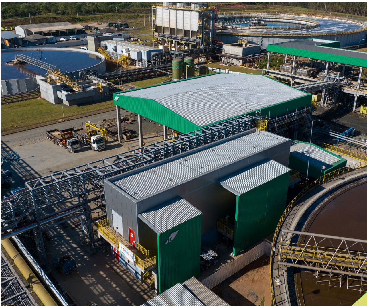
Planta de secagem de lodo na Unidade Ortigueira (PR)
